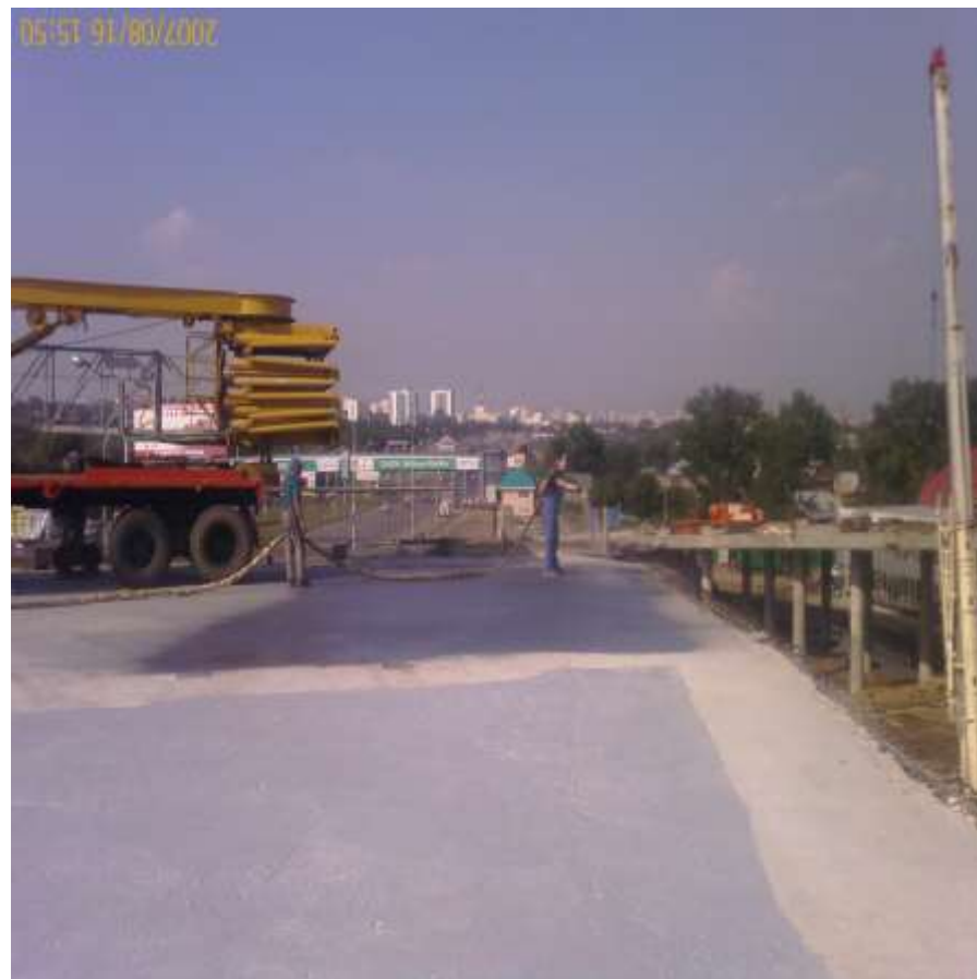
Гидроизоляционные работы, транспортная развязка, г Уфа, 2007 г.
