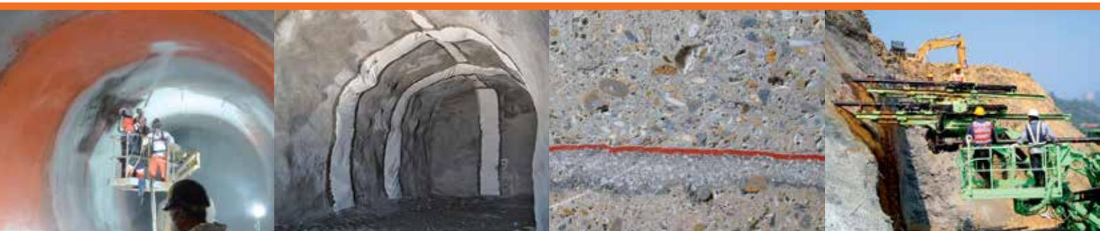
**TamSeal 800** – однокомпонентный напыляемый материал, создающий бесшовную эластичную гидроизоляцию. Напыление осуществляется оборудованием роторного принципа по технологии набрызга. Производительность при возведении напыляемой гидроизоляции TamSeal 800 достигает 200 м<sup>2</sup>/ч и более. Уникальное свойство мембраны прочно сцепляться как с поверхностью различных бетонов (монолит/набрызгбетон), так и с металлами обеспечивает высокую универсальность данной системы.
