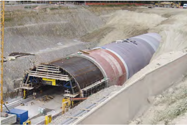
Тоннель Нойфельд, г. Берн, Швейцария
