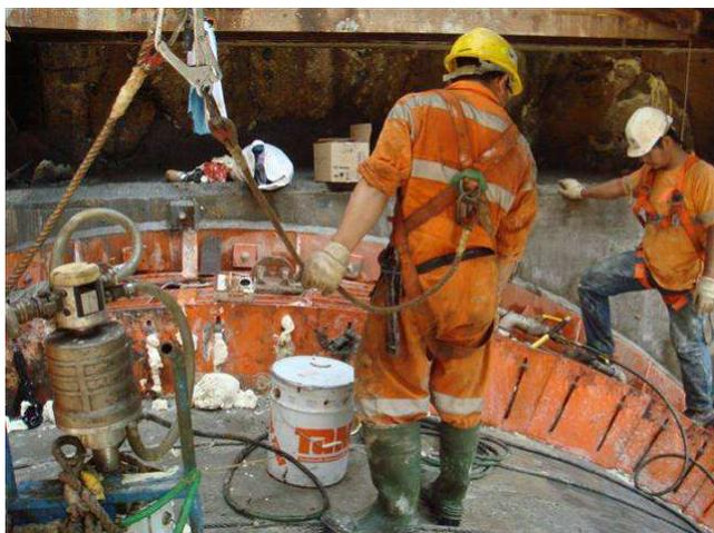
TamPur 130 / TamKat 130 это однокомпонентный тампонажный материал, основанный на смеси метиленадифенил диизоцианата, полиэфиров полиолов и аминовых катализаторов. Система начинает реагировать при контакте с водой, образуя полужесткую пену.
